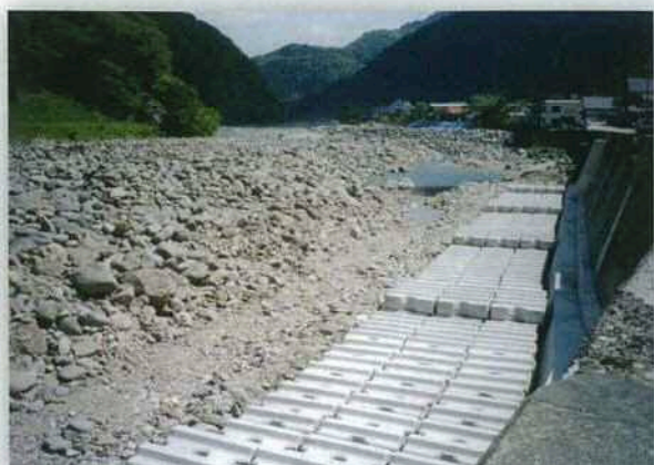
岐阜県 長良川 八幡建設事務所 6t
